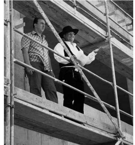
Michael Heine, Polier der Firma BATEG Ingenieurbau GmbH, hielt den Richtspruch. (Fotos: J. Schulz, St. Schwarz, IBMT)
