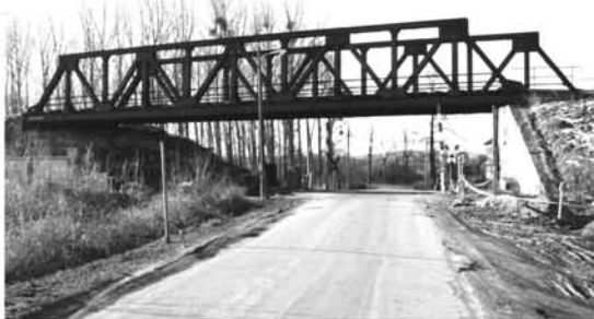
Die Brücke aus dem Jahre 1902 hat ausgedient und wird durch eine neue ersetzt. Das linke Foto zeigt den Bau der neuen Brückenpfeiler. Die neue Brücke ist 1,5 m höher als die alte. ( Alle Fotos S. Seidel)
