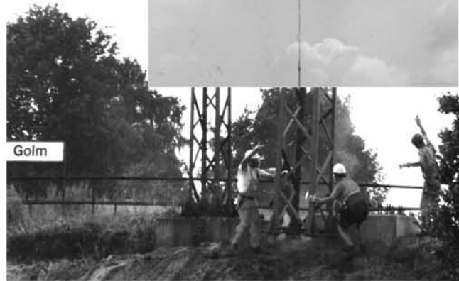
Die Brücke aus dem Jahre 1902 hat ausgedient und wird durch eine neue ersetzt. Das linke Foto zeigt den Bau der neuen Brückenpfeiler. Die neue Brücke ist 1,5 m höher als die alte. ( Alle Fotos S. Seidel)
